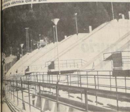
estructura que permite contener las aguas del Río Laja, con una capacidad para un millón de metros cúbicos de agua.
