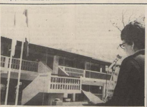
LLAY-LLAY. Frontis del nuevo edificio de la Municipalidad local, inaugurado por el Intendente Raúl López Silva. A la derecha, una dirigente vecinal agradece la obra. El edificio antiguo, señalado, tenía 106 años de vida y se encontraba en ruinosas condiciones.
