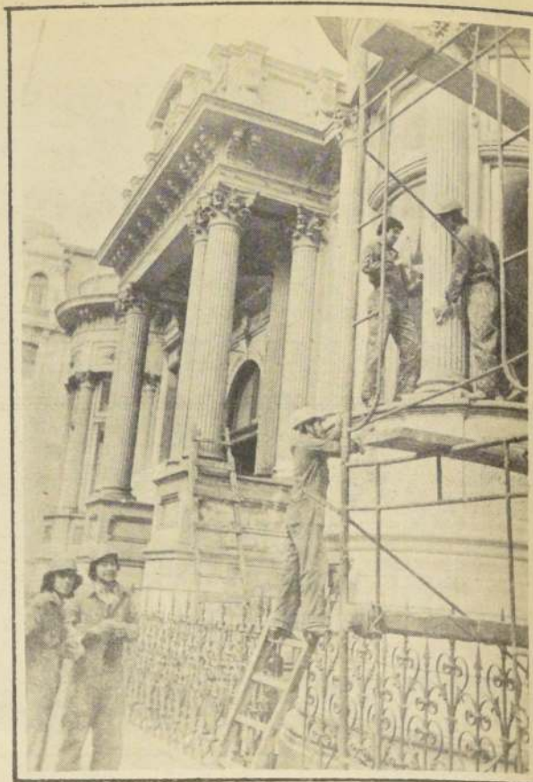
PERSONAL municipal refacciona el ex Palacio Lyon, en calle Condell, a un paso de la Plaza de la Victoria, donde funcionó por muchos años el antiguo Instituto Comercial porteño. La arquitectura, de estilo Renacimiento, y las columnas coronadas con capiteles corintios, dan especial realce a esta hermosa y antigua mansión porteña. La reja de hierro forjado es una extraordinaria obra de artesanía, que se conserva intacta a pesar de tener más de setenta años y estar en clima marino, donde los hierros prontamente se enmohecen.
