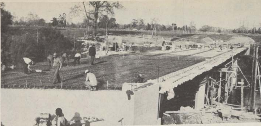
Construcción del puente Rangil en el by-pass de la cuesta Lastarria.
