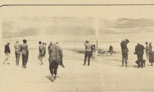
ESPERANZA, chilena. A las 16 horas del domingo 14 de diciembre surgió el primer chorro de vapor geotérmico de la gigantesca caldera del Tatío. Su potencia inicial era suficiente para alimentar una planta eléctrica capaz de generar de 1.000 a 1.500 Kw.
