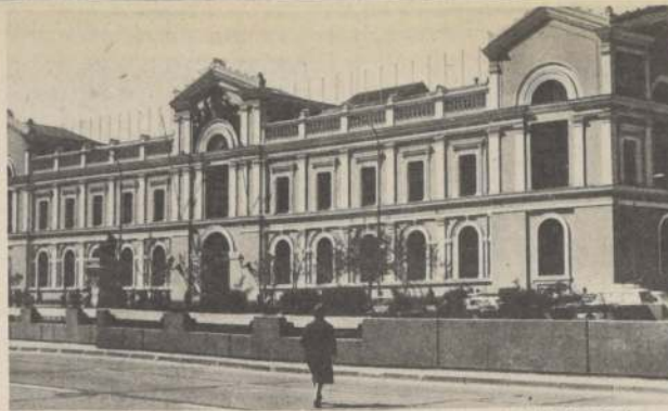
Esta es la fachada de la Casa Central de la Universidad de Chile, cuya construcción se inició el 30 de marzo de 1863, como Palacio Universitario. Su estilo neoclásico marcó un verdadero hito urbano.
