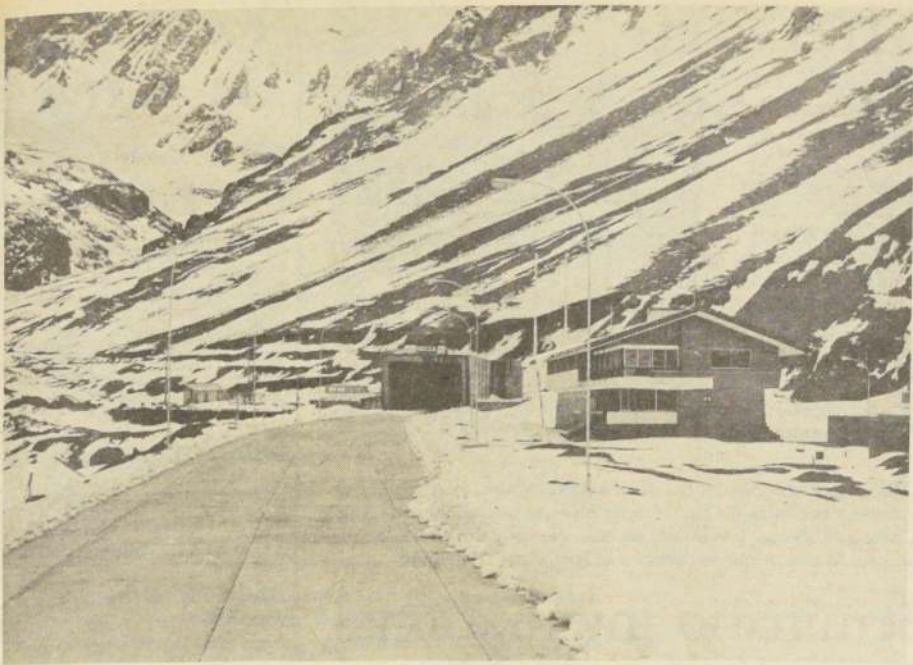
La calzada antes del portal de acceso del sector chileno del nuevo túnel internacional, ya fue terminada por Obras Públicas de Chile.
