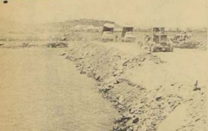
UN AÑO DE CONSTRUCCION lleva el nuevo puente de San Vicente, que será la principal vía de salida en el complejo portuario de las provincias de la Cuenca del Bío Bío, y especialmente, de la zona industrial de Concepción. Se calcula que esta obra, que estará lista a comienzos de 1972, movilizará un millón de toneladas anuales de carga y los rellenos permitirán ganar 21 hectáreas al mar. El costo del puente alcanza a 120 millones de dólares y parte de su financiamiento se realiza con un préstamo de la Misión Económica de los Estados Unidos, dentro de la Alianza para el Progreso. En el grabado, un aspecto de los trabajos que se realizan actualmente.
