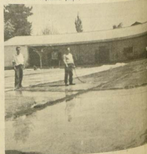
La multicancha de la Escuela E 202 de Rosario estará terminada a final de mes.
