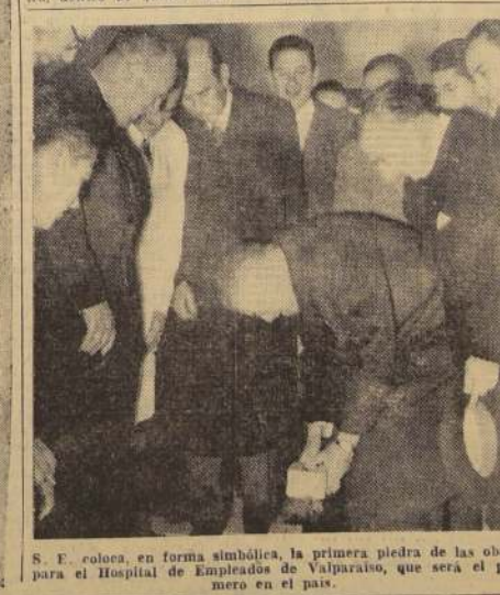
S. F. coloca, en forma simbólica, la primera piedra de las obras para el Hospital de Empleados de Valparaíso, que será el primero en el país.
