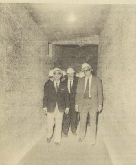
El Secretario General de la Contraloría General de la República, Jorge Reyes, el Director de Arquitectura del Ministerio de Obras Públicas, Sergio Gómez, el Arquitecto Provincial, Lúgardo Cofré, y técnicos de ambos servicios durante la visita a los trabajos de ampliación del edificio de la Contraloría. El inmueble formará parte del Conjunto Cívico Moneda, constará de nueve pisos y su superficie será de 7.960 m 2 . Estará concluido a fines de 1975.
