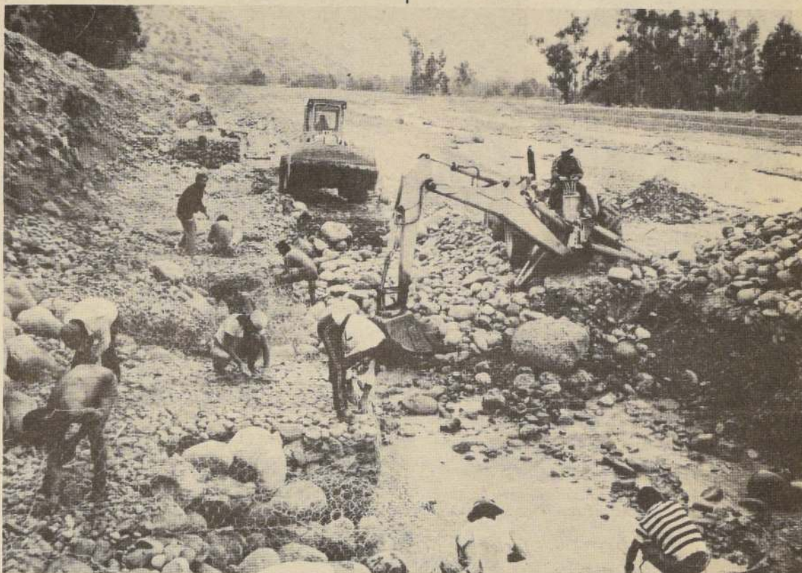
El arreglo de las riberas del Mapocho, con las instalaciones de gaviones destinados a evitar el rebase
