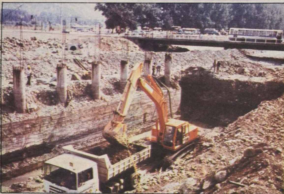
Trabajos de encauce del río Mapocho, en el sector La Pirámide, en Las Condes, donde se proyecta construir un moderno nudo vial.
