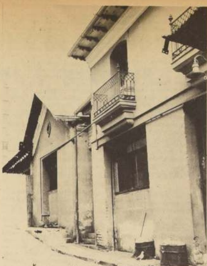
Su estado es deplorable, ruinoso. Los habitantes del barrio dicen que es un refugio de prostitutas.
