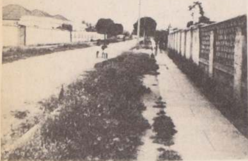
Una calle de la comuna de La Cisterna, la Jorge Luco. La comuna se ha modernizado y muchas de sus calles tienen luces de mercurio, pero habitualmente éstas son destruidas por vagos que pululan por todos los sectores.
