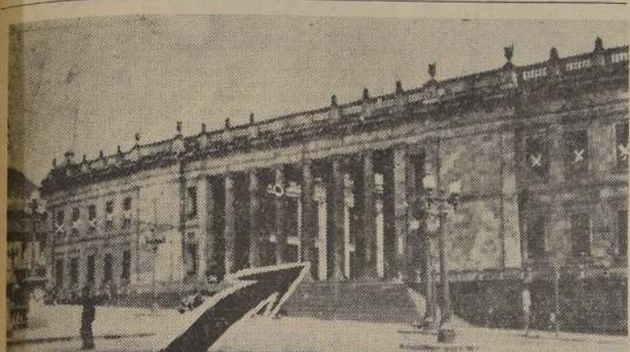
Fachada principal del Capitolio, edificio asaltado ayer por una poblada revolucionaria. La flecha indica la entrada del edificio por donde se precipitaron los asaltantes al interior, donde ocasionaron graves destrozos. Afortunadamente, ayer no era día de Asamblea General en la Conferencia, motivo por el cual la asistencia al Capitolio no era numerosa.
