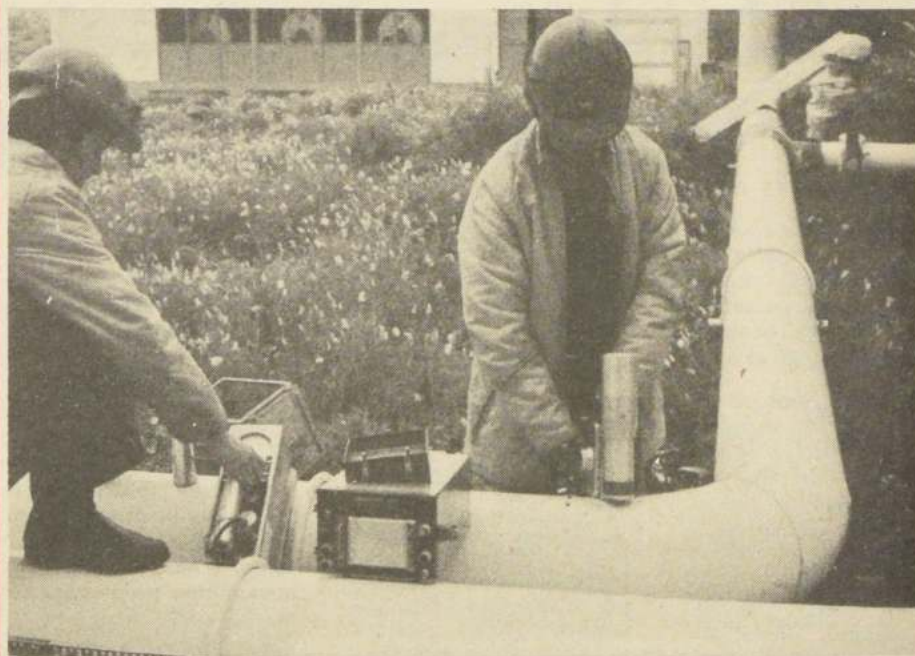
TECNICOS utilizan complejos aparatos para medir caudales y determinar una probable filtración en estas tuberías.
