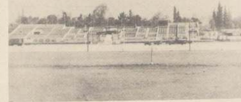
Así se veía ayer la Elipse del Parque O'Higgins, lista, barrida, regada y "soplada" para la Parada Militar de hoy. Hace un mes comenzaron los trabajos de acondicionamiento.
