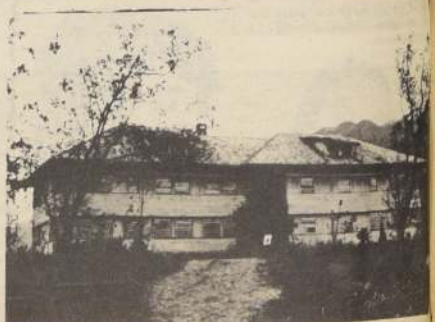
Hotel que se construyó en Laguna San Rafael el año 1942 y que posteriormente fue saqueado por los piratas de los canales. Hoy es totalmente tapiado para evitar su destrucción total. Construcción de 3 pisos y en época fue uno de los grandes hoteles del país.
