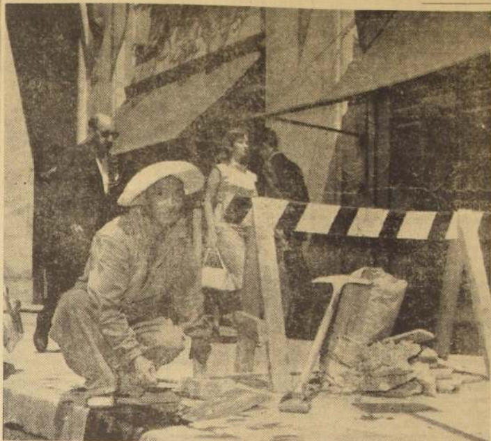
Esta escena corresponde a las diarias faenas que se realizan en Santiago para reparar su asfáltico pavimento o abrir sus aceras para instalar los cables de energía que dan vida a los peatones: semáforos automáticos.
