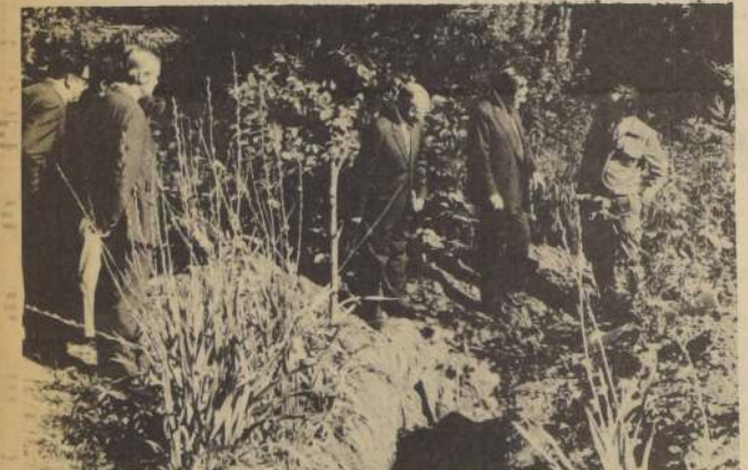
YA SE ESTAN INSTALANDO las primeras estructuras metálicas para la Primera Feria Internacional de Valparaíso que se inaugura en noviembre próximo y que tendrá carácter permanente. Los terrenos ubicados en Villa Lenin, ex Quinta Alfaro fueron visitados por el alcalde Pedro Vuscovic Rojo y Jefe de Servicio.
