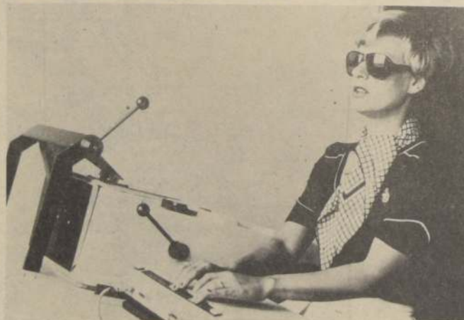
La Telefunken ha construido un nuevo aparato electrónico, revolucionario en su género, que permite a los no-videntes la lectura, línea por línea, de libros y carillas, y su conversión o reproducción en el sistema Braille. Este aparato, que vemos en fotografía, facilita el empleo de ciegos en las oficinas privadas o de la administración pública. Los mismos ingenieros especializados están desarrollando ahora un aparato que convierte directamente la palabra escrita en lengua humana.
