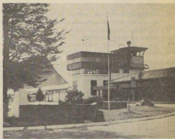
TORRE DE CONTROL y jardines del Aeropuerto de "El Tepual", donde se han efectuado importantes trabajos de repavimentación de la pista de aterrizaje.
