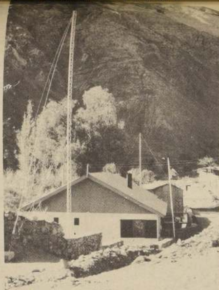
ANTENAS DE ONDAS CORTAS (HF) DE LA RED TARAPACA, UBICADA EN LA LOCALIDAD PRECORDILLERA DE HUTACONDO (Foto R. Sotomayor).
