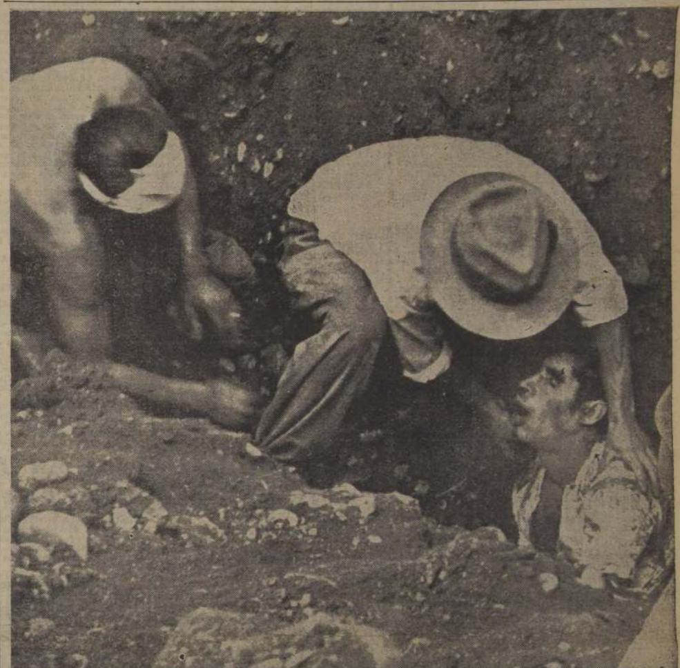
EL CADAVER DEL OBRERO EDUARDO CUELLAR, en los momentos en que es rescatado del derrumbe por dos de sus compañeros de trabajo. Cuéllar recibió una muerte instantánea, al quedar sepultado bajo cinco toneladas de piedras y tierra, en la construcción del teatro de la SATCH, en la calle San Diego.
