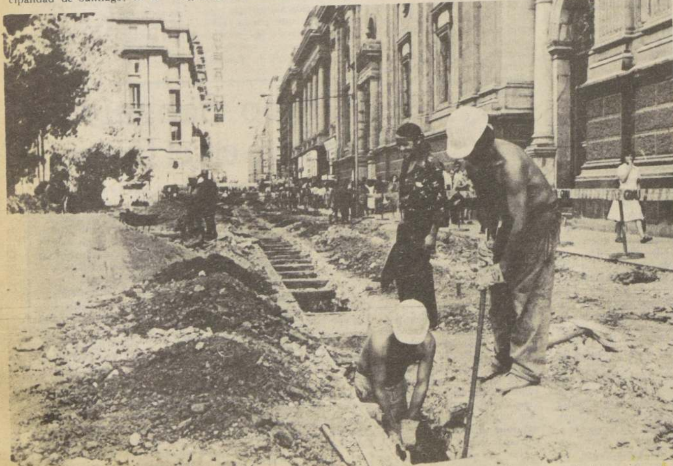
Los obreros trabajan para sacar los rieles que un día sirvieron de vía a los carros de locomoción colectiva, para completar desde la Alameda a Catedral, el Paseo Ahumada.
