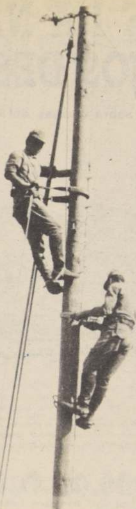
Personal del Regimiento "Tucapel" procede a la postación e instalación de cables para energía eléctrica, en una de las comunas de Cautín, cumpliendo así una de las labores ordenadas por las autoridades militares para sacar a la provincia de su tradicional abandono.
