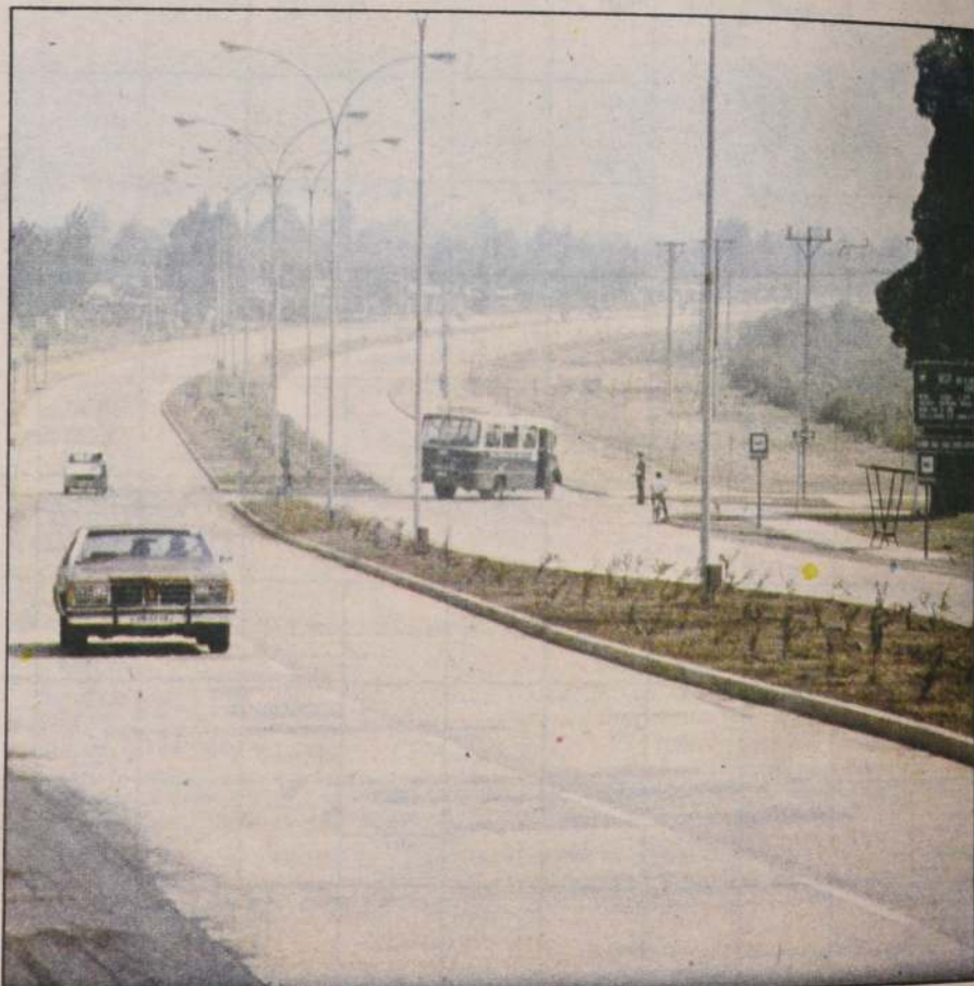
Más de dos kilómetros de doble calzada pavimentados conectan Conchalí con Las Condes. La obra incluye saneamiento, semaforización e iluminación.
