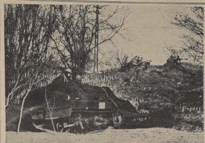
Los preparativos de defensa en Gran Bretaña se aproximan a su punto de máxima eficiencia. Los caminos y carreteras que meses atrás habían sido cerrados con la colocación de sacos de cemento, ahora son puestos nuevamente en servicio en virtud de que existe ya un número más que suficiente de fuerzas territoriales excelentemente equipadas y adiestradas en el uso de las armas, las cuales están en situación de tomar la ofensiva contra cualquier invasor. El grabado representa un aspecto de muchos que son ya familiares para los ingleses: un tanque liviano, rodeado de observadores que avizoran la proximidad eventual de un enemigo que hasta ahora no ha dado grandes señales de vida.
