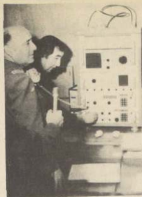
Con modernos equipos Skanti, de fabricación holandesa, cuenta la sala de radio de la Gobernación de Iquique, con lo cual podrá comunicarse con 31 pueblos del interior. En el grabado, el Intendente Juan Guillermo Toro Dávila visita las instalaciones.
