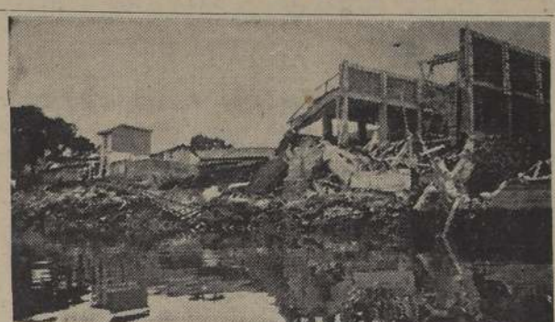
Militar, capitán de fragata Luis Urzúa Merino, ha debido proceder con firmeza para demoler las que estaban en peor estado. Vió también el peligro que es para los pobladores de la ribera, una nueva crecida del río, y constató el estado de ruina de la Escuela Industrial, en construcción, cuyas fundaciones quedaron en el aire, y sus vigas y muros quebrados. Ante tanto desastre, el Ministro Latorre impartió órdenes de reconstrucción inmediata. En el grabado vemos, a la izquierda, la lancha a motor "Navade", varada en la calle Echeverría, a escasas 2 cuadras de la Plaza de Armas. A la derecha, un aspecto captado, desde el río, de la Escuela Industrial. En ese sector las aguas hicieron desaparecer una franja de terreno de más de 15 metros de ancho, en la que había modestas viviendas.
