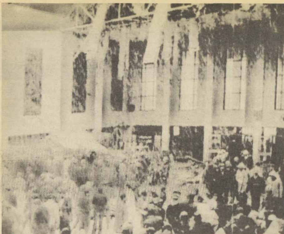
TEHERAN, Irán.— Patrullas de rescate remueven los restos de la principal terminal de aeropuerto que se derrumbó ante el peso de la nieve acumulada,
