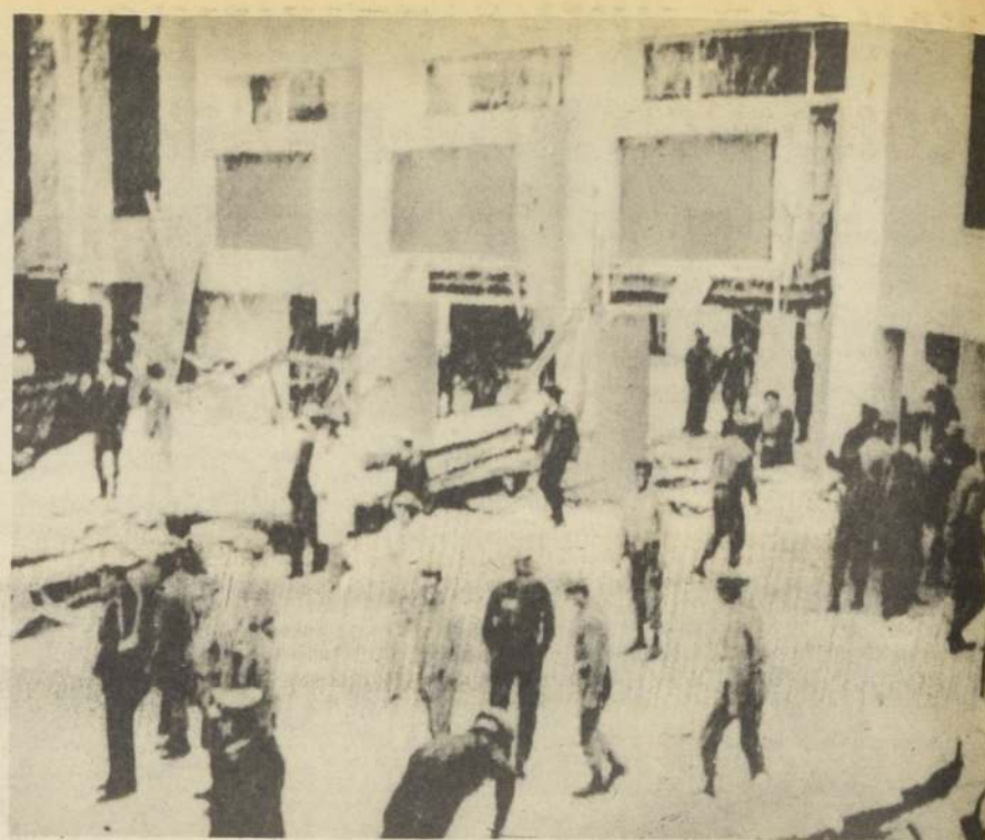
causando por lo menos la muerte de 50 personas. En el otro grabado, se puede apreciar otro aspecto del estado en que quedó el edificio. (RADIOFOTO UPI).
