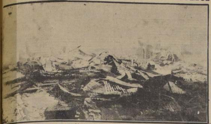
Escombros a que quedó reducido el establecimiento incendiado
