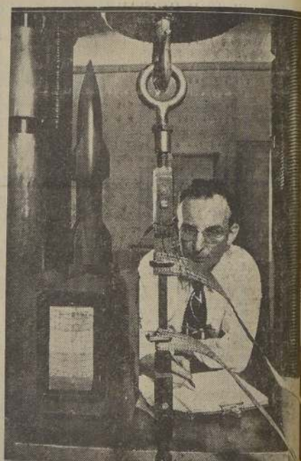
Los ingenieros de la General Electric se encuentran en realizar "vuelos de prueba" de trozos de metal que se emplean en la construcción de proyectiles y cohetes dirigidos. La fotografía muestra al ingeniero W. E. Manning, se encarga de simular las condiciones de temperatura y encontrará un proyectil en su trayectoria. Y para ello corrientes eléctricas que producen calor desde 25 hasta 200 grados C. por segundo, las que son aplicadas a las muestras metálicas. Mediante una larga serie de pruebas en que se rompen, los ingenieros pueden hacer comparaciones de diversas cualidades de resistencia de los metales y así determinar cuáles son los que mejor se prestan para la fabricación de proyectiles dirigidos.— (Foto Globe Press).
