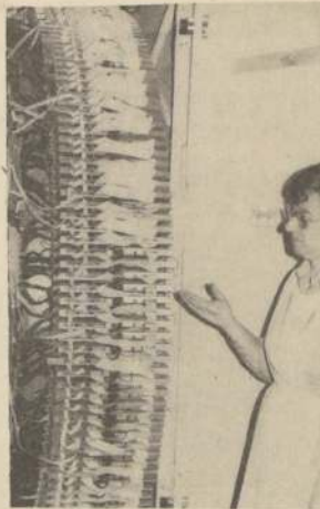
La tecnólogo-médico Esthel Possa indica parte de los 600 detectores que permiten al Scanner explorar escalonadamente y en forma automática el cuerpo humano.
