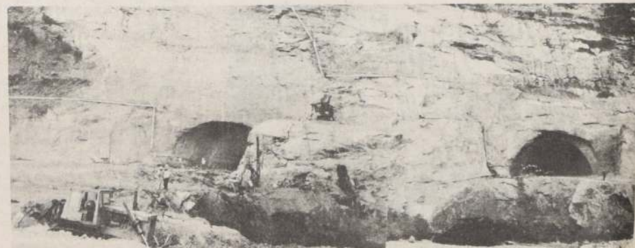
Construcción de túneles efectuados con explosivos ENAEX en central hidroeléctrica Colbún-Machicura.
