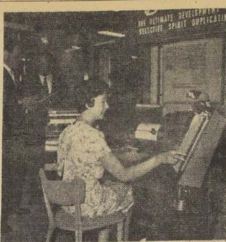
"BANDAMATIC", REVOLUCIONARIA MAQUINA PARA NEGOCIOS.— En la Exposición de Eficiencia de los Negocios, en Londres, se exhibió esta máquina para reproducir documentos, a alta velocidad y de manera nítida. La maneja una sola oficinista y puede también extraer automáticamente grupos de documentos o determinados.— (Foto BIPPA)
