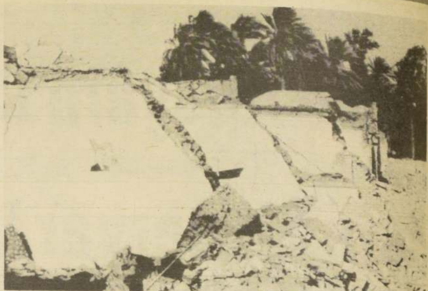
LA FOTO ILUSTRA la fuerza del terremoto de Irán: los muros de adobe fueron rasgados como si fueran de papel por los remezones de la tierra. Esto quedó de una escuela de Tabas.
