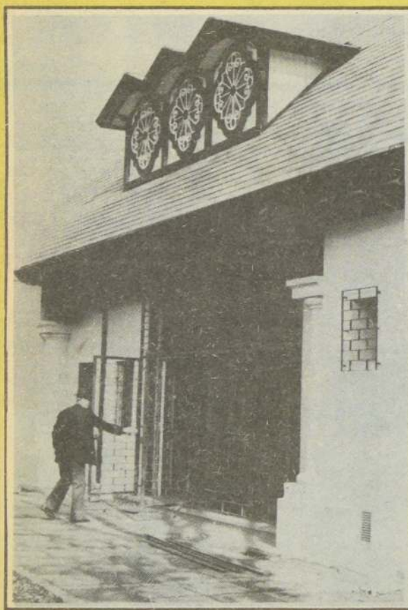
SE ESTAN DANDO los últimos toques al moderno edificio donde se instalará la Filmoteca Genealógica Pública, de la iglesia mormona de Santiago.
