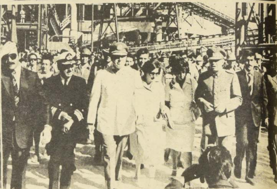
El Jefe de Estado, junto a la Primera Dama de la Nación y comitiva, recorre las instalaciones de la Planta de Pellet, luego de inaugurarla, en el puerto de Huasco.
