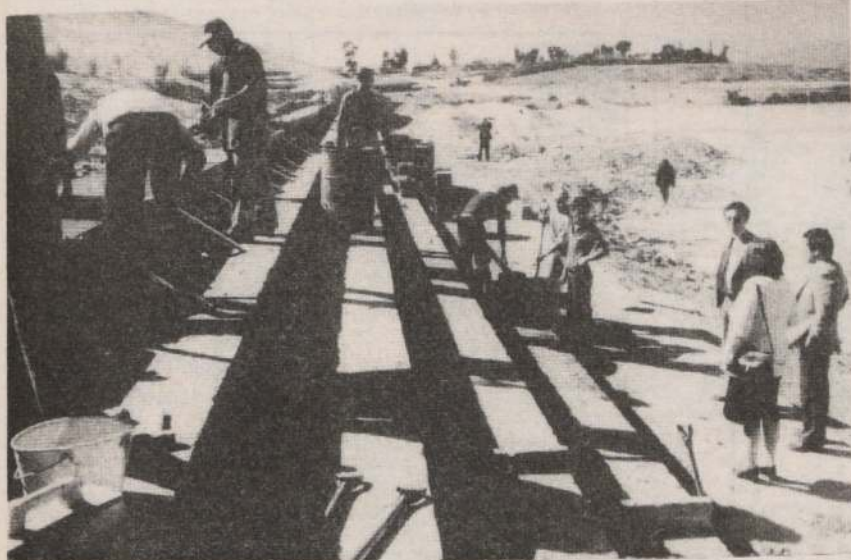
Aproximadamente 3.500 ladrillos han sido ya colocados en las graderías de la futura Villa Olímpica de Quilpué por dos cuadrillas POJH, destinadas a estas obras.
