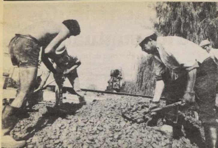
Reparación de baches y repavimentación parcial de tramos carreteros, incluye la extensa lista de trabajos recién terminados por Vialidad en las zonas centro y sur del país.
