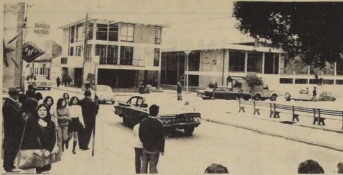
COQUIMBO. En un acierto fotográfico se muestran los nuevos edificios de la Gobernación Departamental y de Correos y Telégrafos de esta ciudad.
