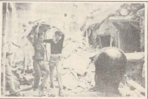
EL CAIRO, Egipto.— Cuadrillas de rescate transportan el cuerpo de una persona herida en el derrumbe de un edificio de cuatro pisos en esta capital (Radiofoto UPI).
