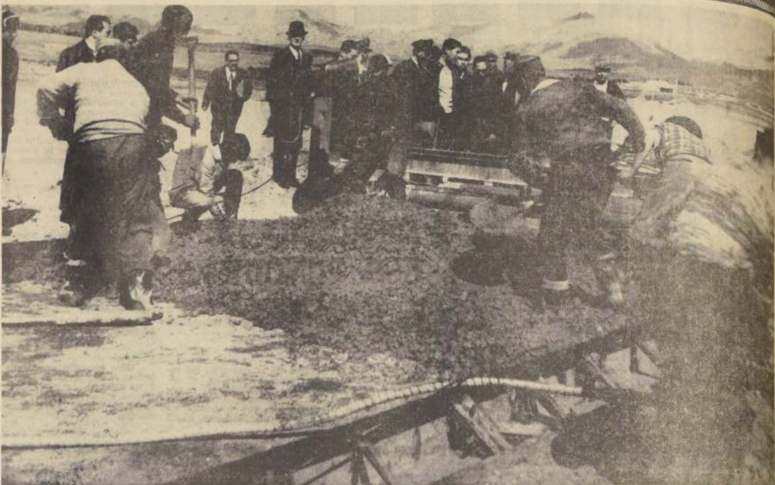
Aceleradamente se trabaja en las obras del aeropuerto de Balmaceda. Autoridades del Ministerio respectivo, señalaron que dicho centro de comunicación de la provincia de Aisen, entrará en funciones en el mes de febrero del próximo año. El grabado registra la labor que despliegan obreros, en la pavimentación de esa pista.
