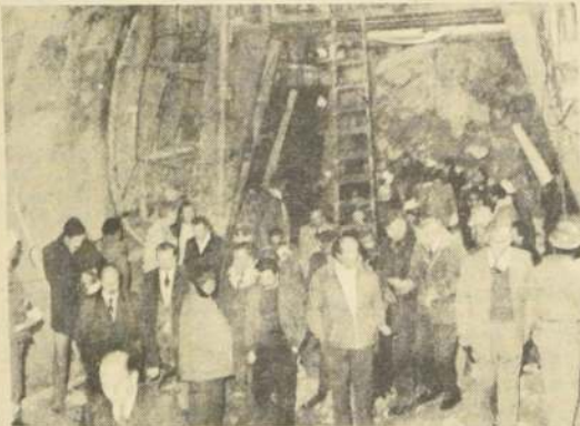
Un aspecto del estado en que se encuentran las obras de construcción del túnel "Cristo Redentor", que en el lado chileno acusa un avance de un 60 por ciento.
