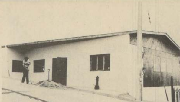
La fotografía ilustra los trabajos de habilitación de la sede social de la Junta de Vecinos y organizaciones comunitarias de la Población Deportes Recreo, que será entregada hoy a las 19 horas, por el Alcalde viamarino Edmundo Crespo Pisano.
