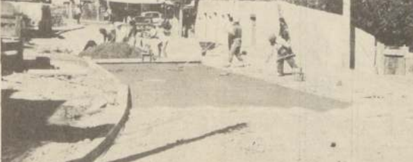
PAVIMENTACION.— Nuevos trabajos de pavimentación en vías de acceso de las poblaciones de la parte alta de Viña del Mar inició la Municipalidad local. En el grabado, obras correspondientes a calle Esmeralda en población El Gran Esfuerzo.
