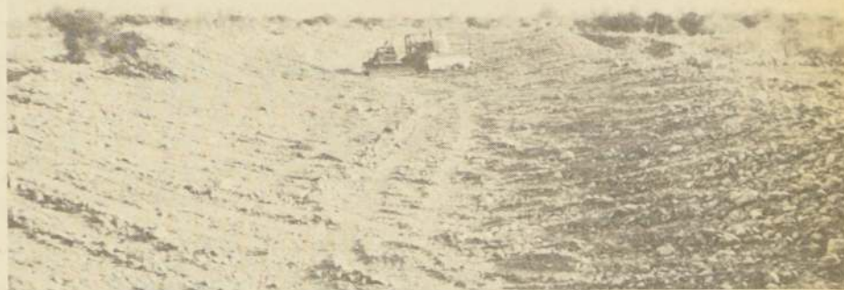
El Departamento de Obras Fluviales de la Dirección de Vialidad finalizó las obras de encauzamiento que permiten proteger de crecidas y aluviones invernales el camino que une a Tiltit y Polpaico en la Región Metropolitana.
