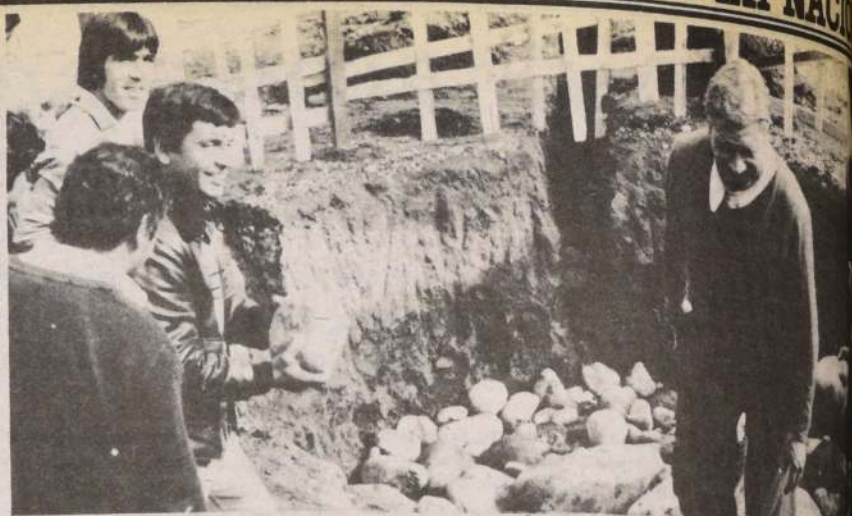
Tres grandes pozos se están construyendo en San Luis de Macul para absorber las aguas que se escurren el período invernal.
