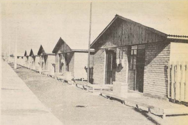
Un conjunto de 532 casas construirá el Ministerio de Vivienda y Urbanismo en la IV Región.
