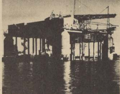
UN MONSTRUO FLOTANTE es la plataforma que llegará a nuestro país para hacer perforaciones de sondeo en la plataforma continental frente a las costas de Valdivia. Mide 70 metros cuadrados y permite perforar hasta 20.000 pies de profundidad.
